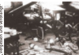
Verwüstetes Gewerkschaftshaus in der norddeutschen Kleinstadt Eckernförde, 10.7.1932
